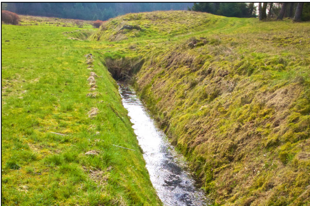
Abb. 11. Entwässerungsgraben am Fusse der Messbrunnengruppe
